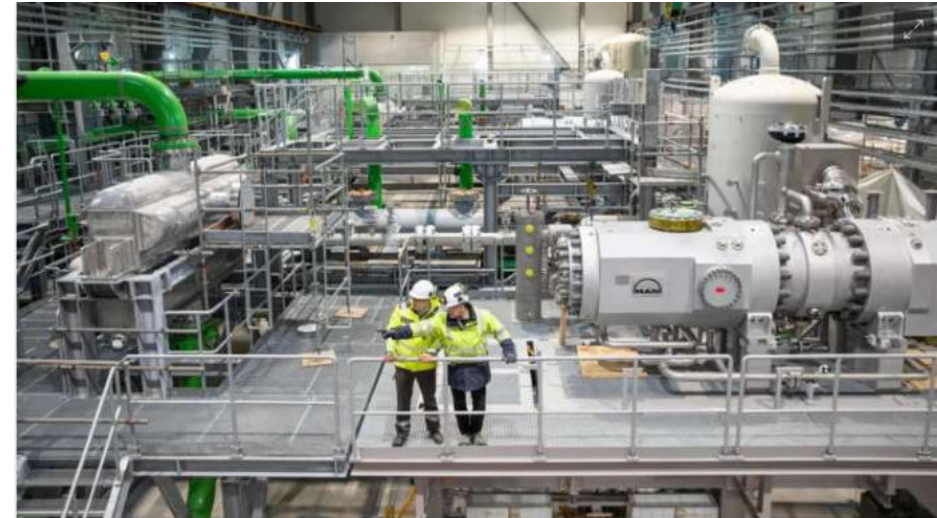
Arbeiter beim Aufbau der Großwärmepumpe im Hafen von Esbjerg. Foto: MAN Energy Solutions Switzerland
